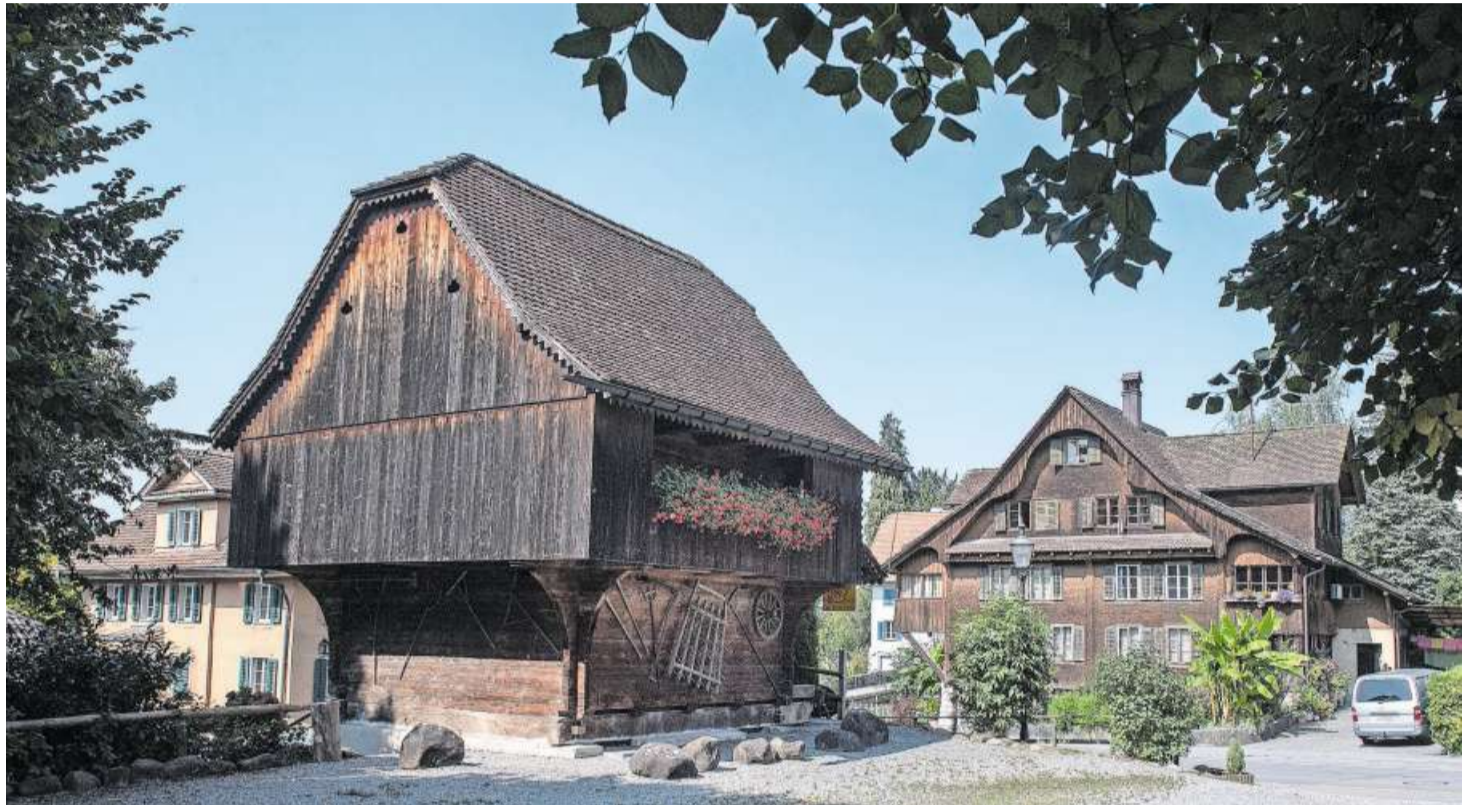
Noch steht der Spycher an der Neumattstrasse, nahe der katholischen Kirche.
